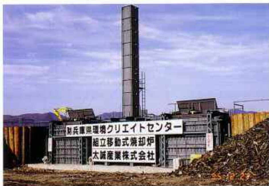
【木くずの焼却施設（2基）、燃え殻→フェニックス】
