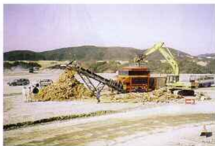
【破碎機の稼働】
