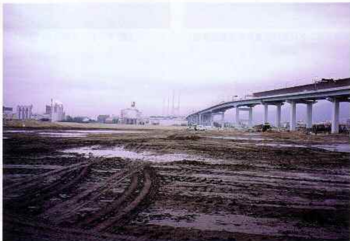
【災害廃棄物を全て処理した跡地の全景】
