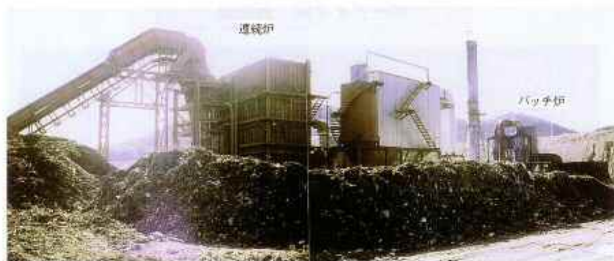
【焼却炉の稼働】
