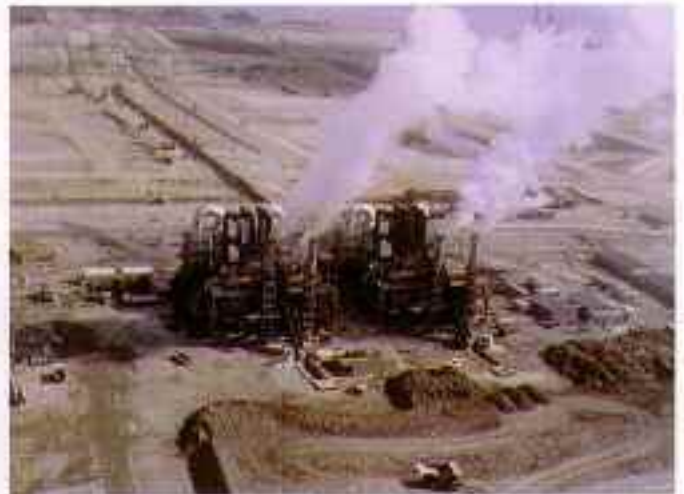
【焼却炉（連続炉）の稼働】
