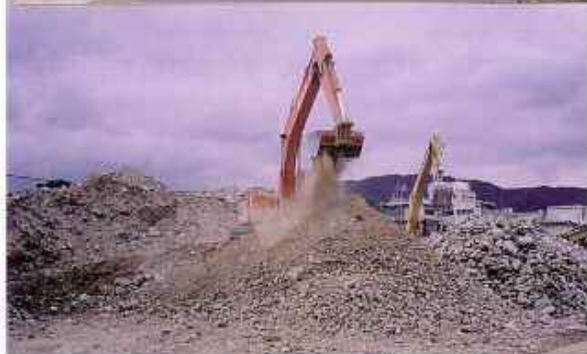
【コンクリート・がれき等の重機による選別状況】
