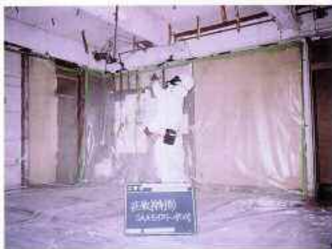
【飛散抑制剤の吹付作業】
