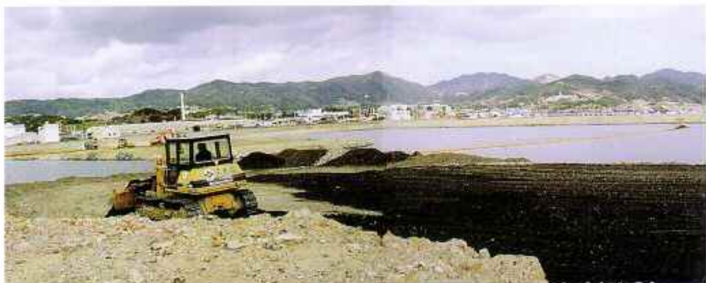
【津名町生穂地区におけるガレキの海面埋立作業】
