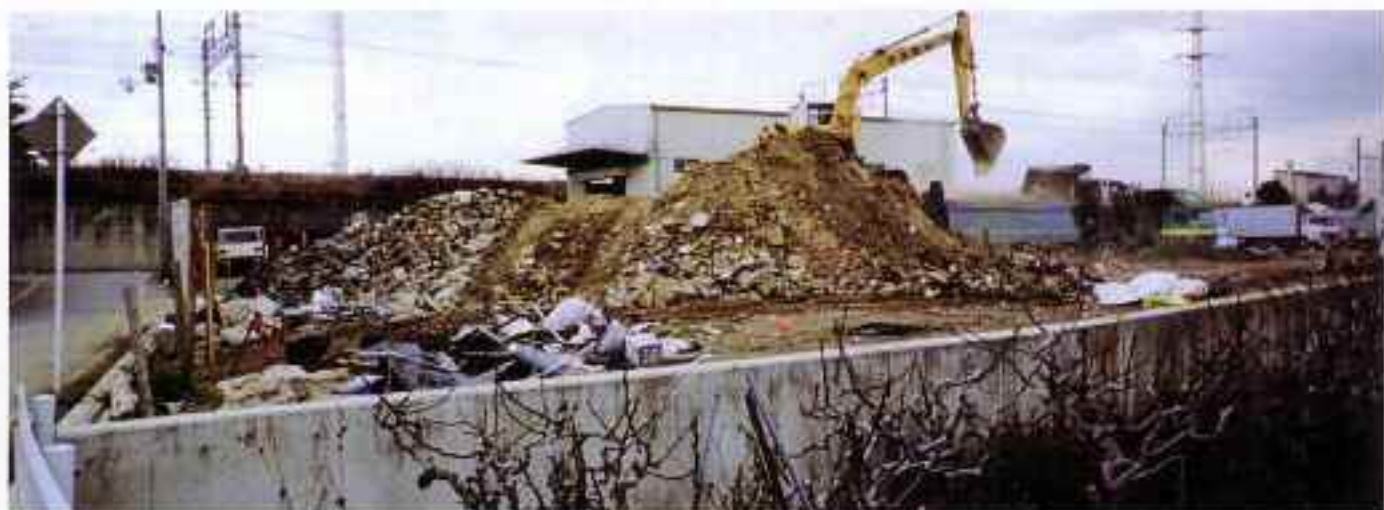
川西市加茂 仮置場 (極東南)
