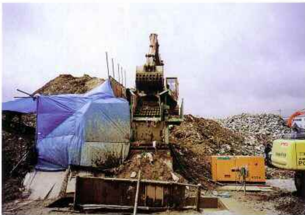
【土砂ふるい機の稼働】
