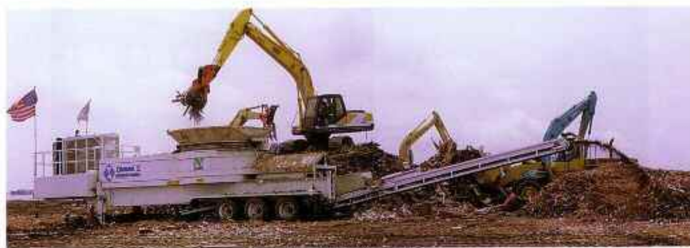
【木くず破砕機の稼働】
