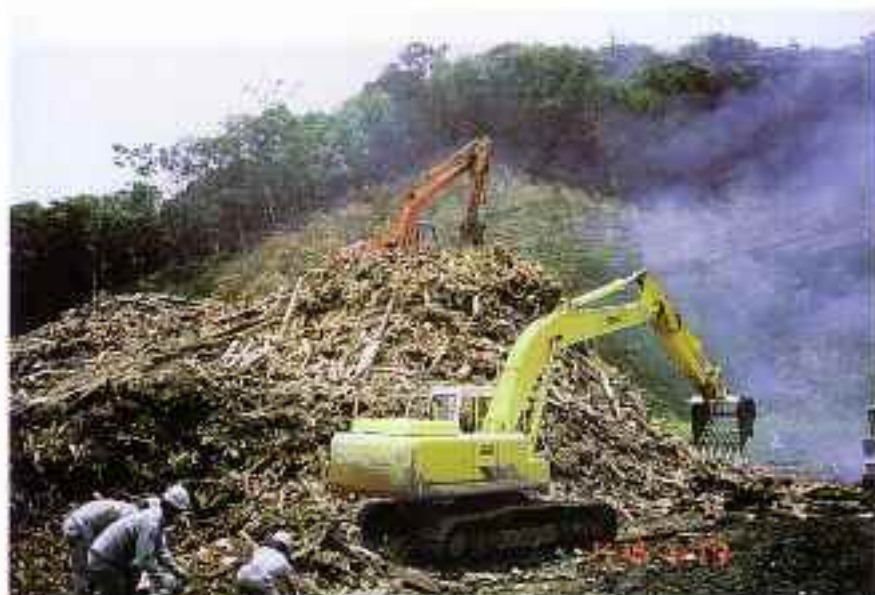
【重機による分別作業】
