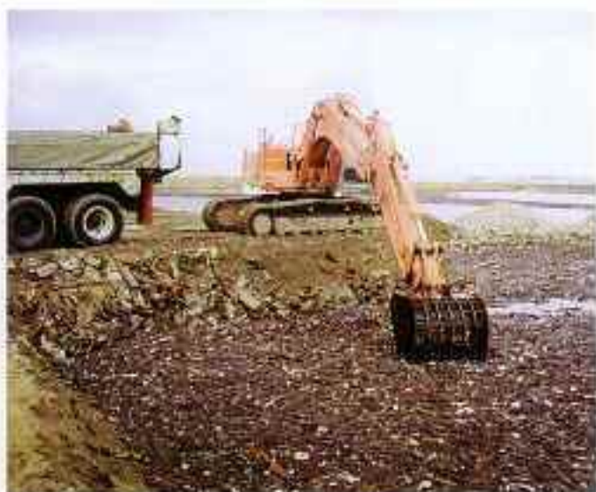
【海面に浮遊した木くずを重機により回収】
