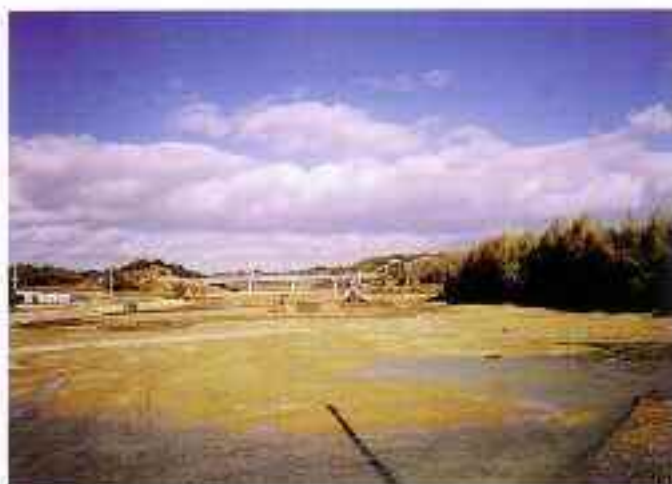
【埋立が進むため池（上大池）の全景】
