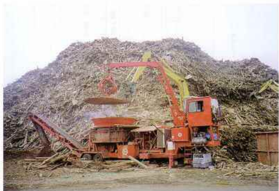
【木くず破砕機の稼働】
