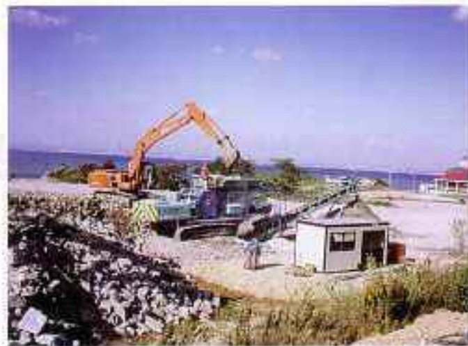
【破砕機の稼働】
