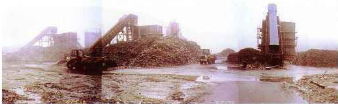
【焼却炉（連続炉）の稼働】
