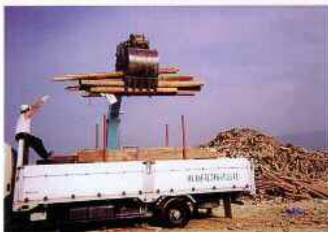
【廃木材の搬出（再資源化）】
