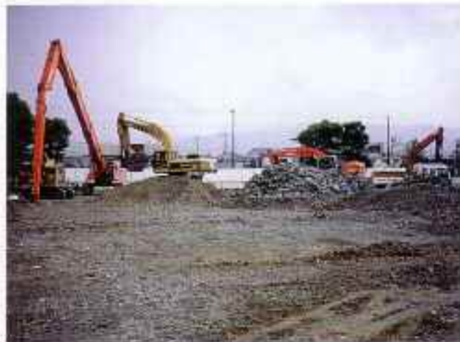
【解体・整地後の状況】
