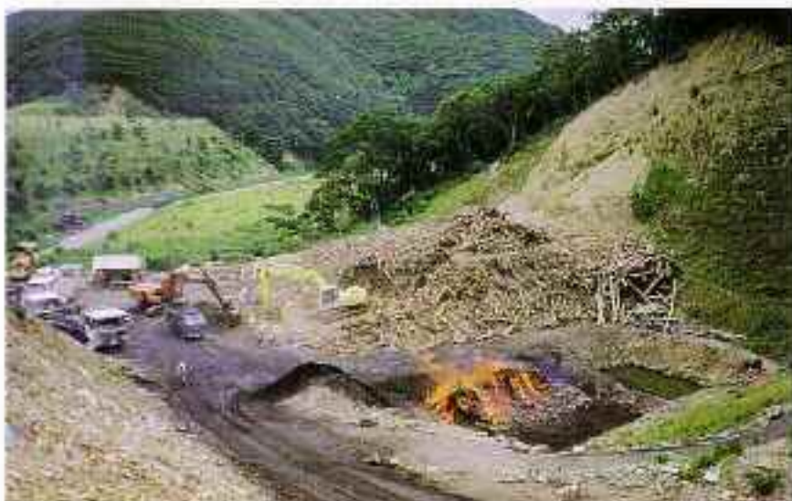
【仮置場の全景】
