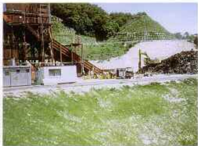
【破碎・分別機の稼働】
