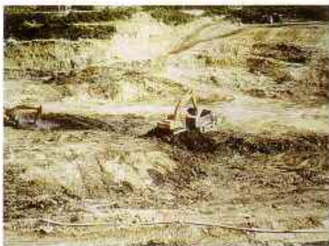
【廃棄物の掘り起こし作業】
