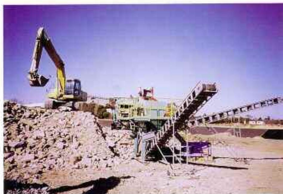
【不燃系・破碎机（碎石）→再生】
