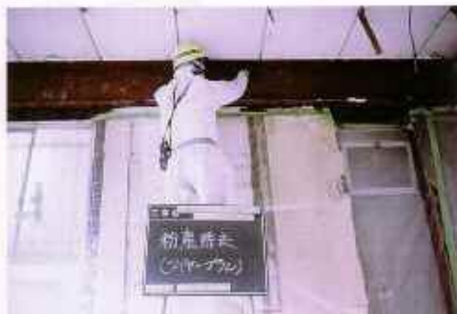
【アスベストの除去作業】
