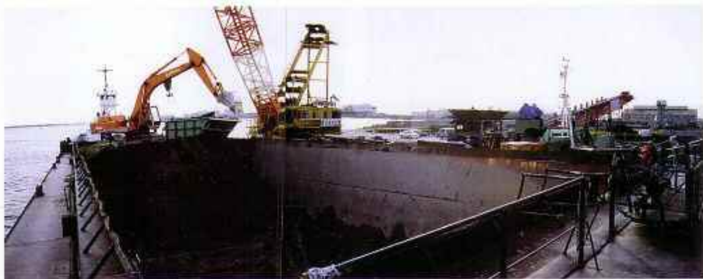
【船舶（バージ船）からの揚陸作業】
