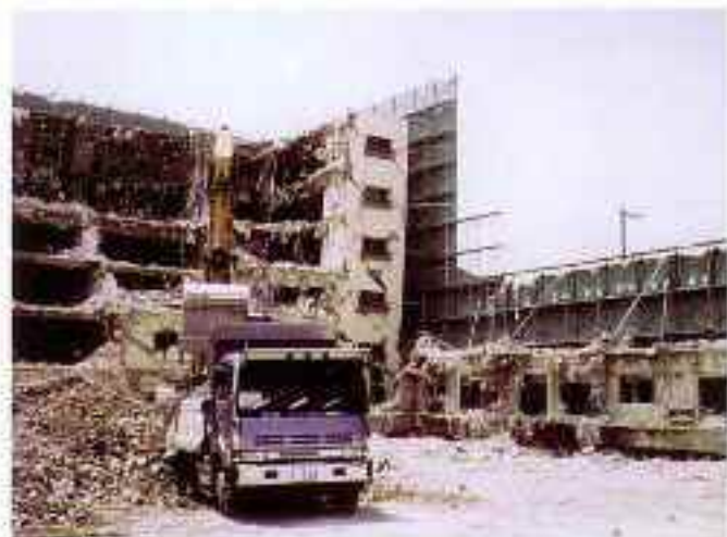
【解体ガレキの搬出】
