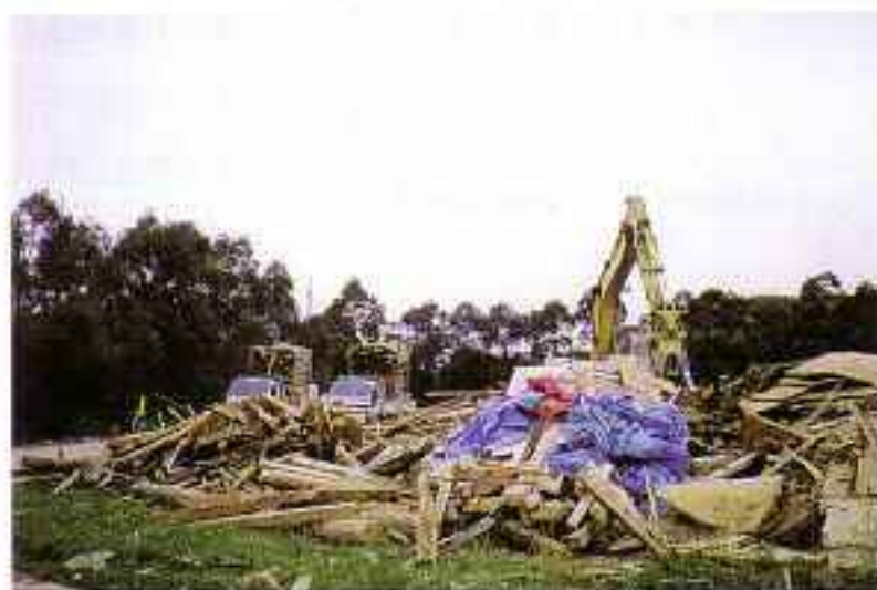
【廃木材の集積・搬出場（再資源化）】
