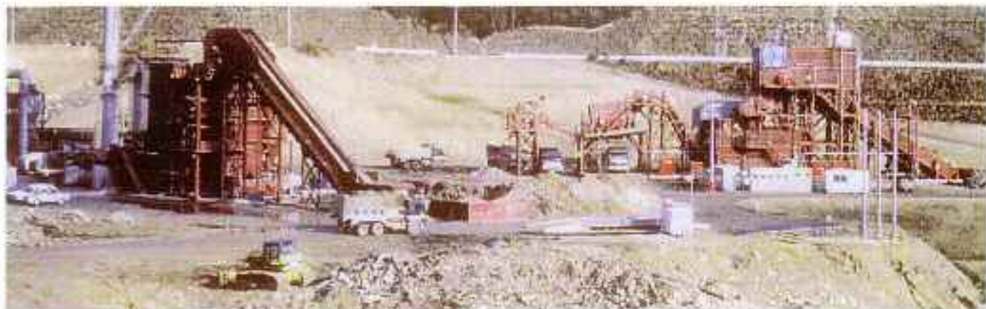
【焼却炉、破碎・分別機の全景】
