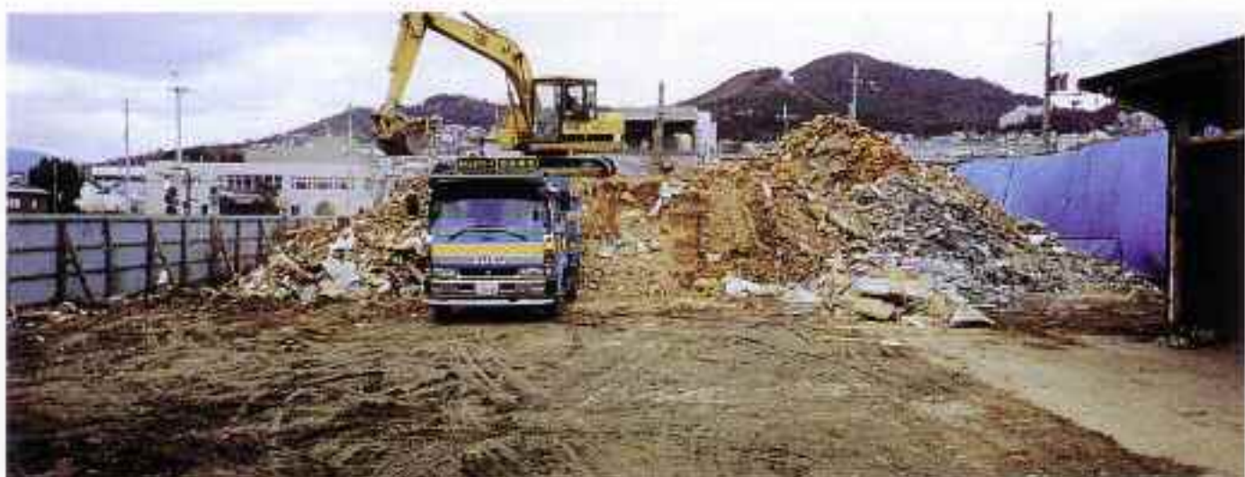
火打 仮置場 (ふれあいプラザ)
