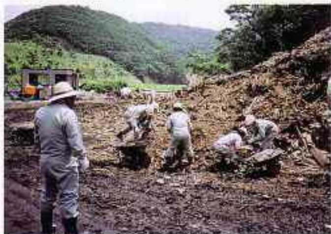
【破碎木くずの搬出→姫路網干処分場】
