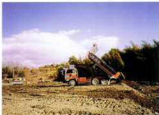
【碎石・土砂のため池埋立作業】
