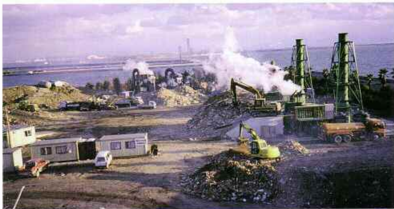
【焼却炉（6基）の稼働】
