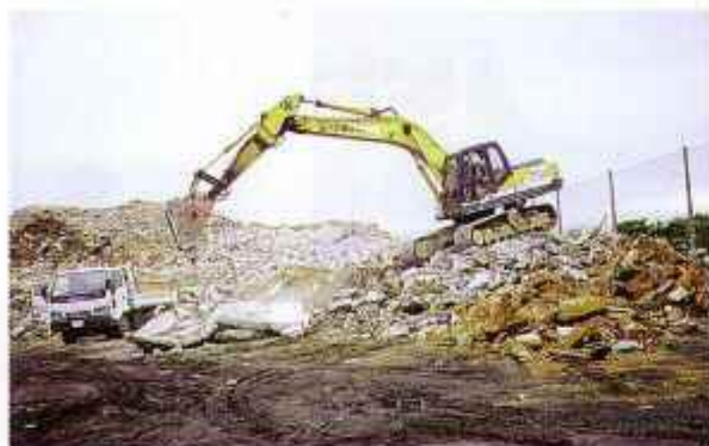
【バックホーによるガラスの破砕】
