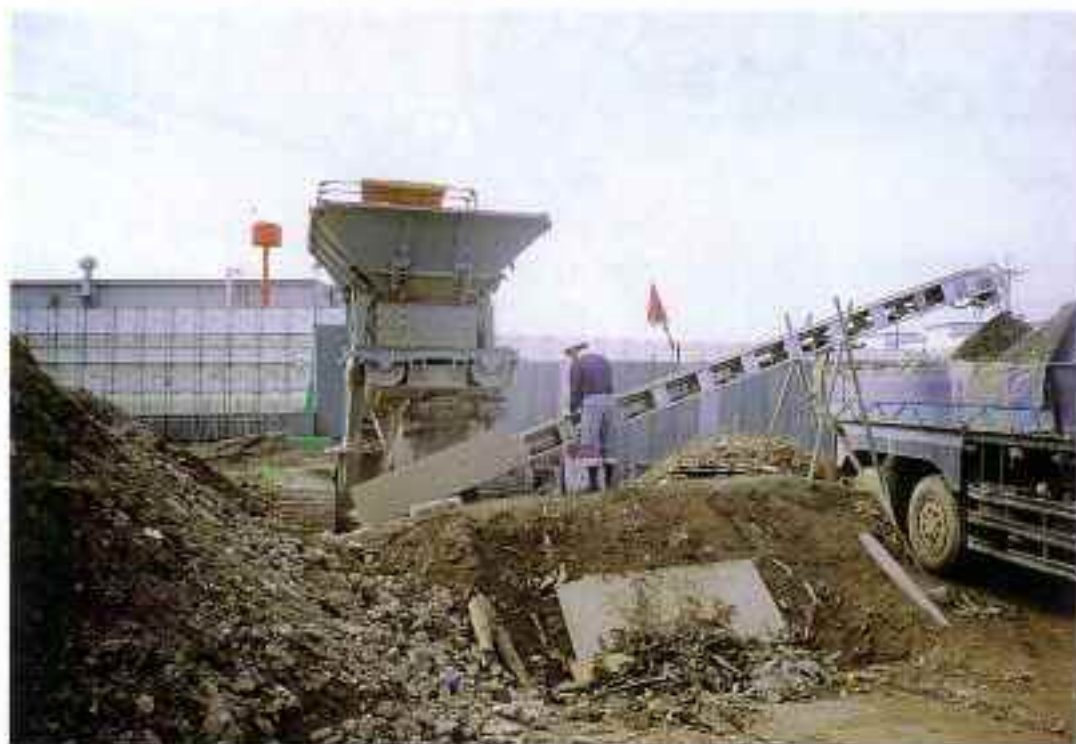
【コンクリートガラの破砕機】
