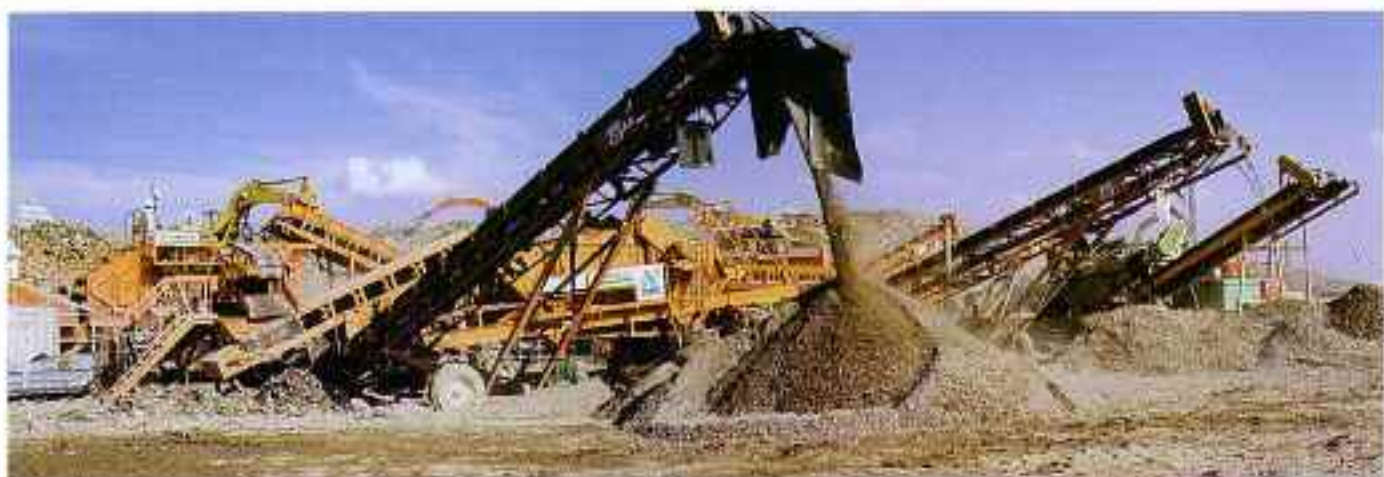
【破碎・分別機の稼働】
