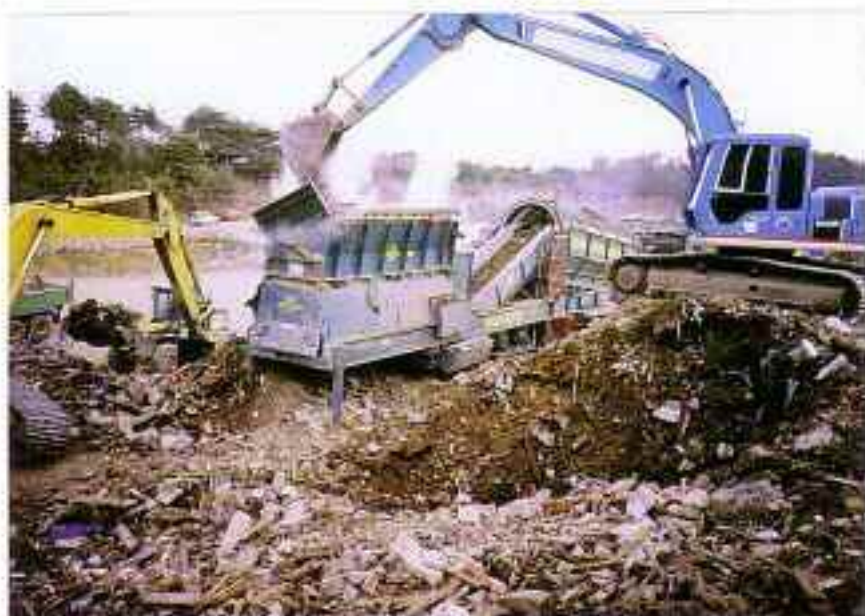
【不燃系・ふるい機（土砂）→再生】
