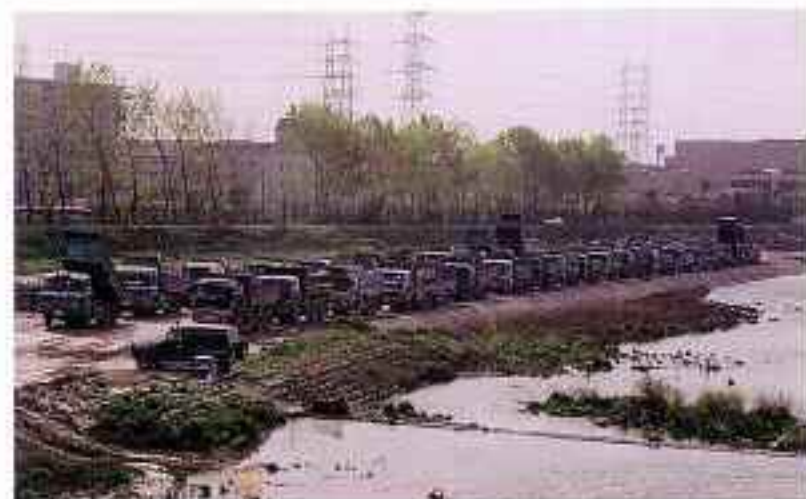
【コンクリート・ガレキの搬出車両】
