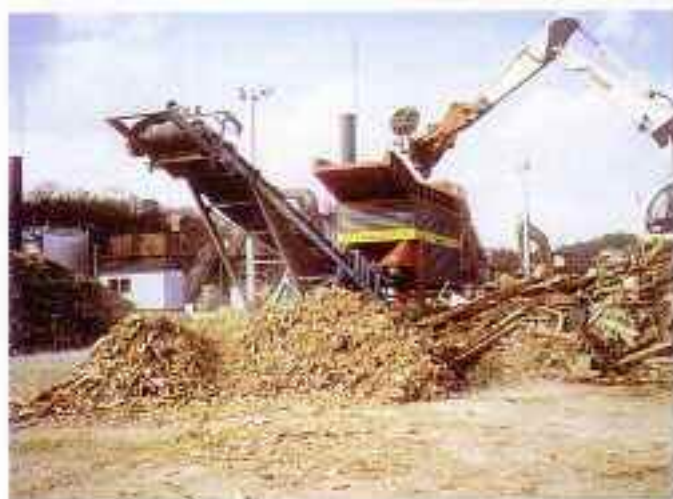
【粗大木材の破砕機（ガリバー）】
