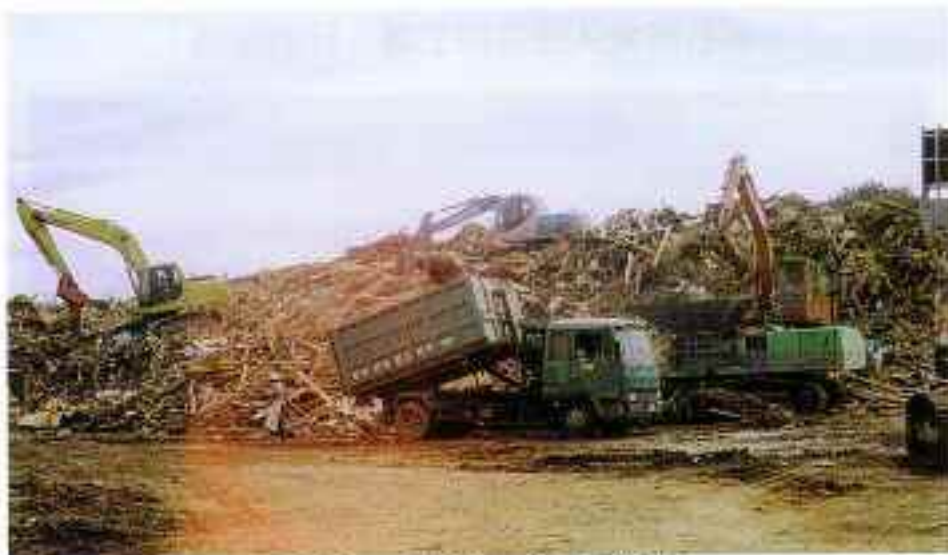
【可燃系廃棄物 搬入現場】
