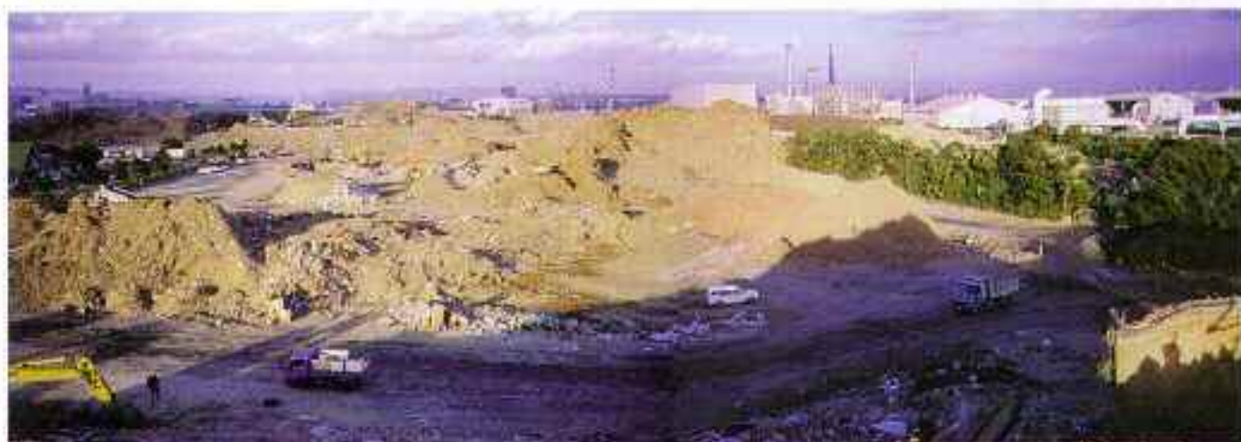
【仮置場の全景】
