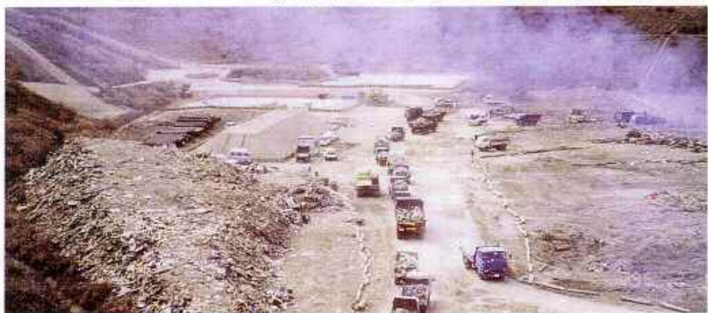
【災害廃棄物の搬入状況】
