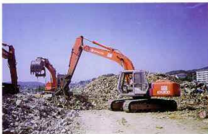
【重機による分別作業】
