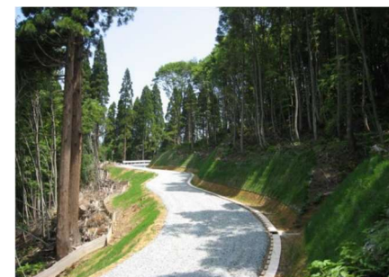
林道設計における現地地形に沿った波型線形の採用 (在来種の生息・移動空間の確保)
