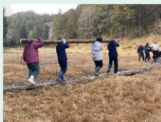
湿原内の木道の修繕
