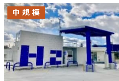
ネッツテラス三木 水素ステーション(R6.3開所)
