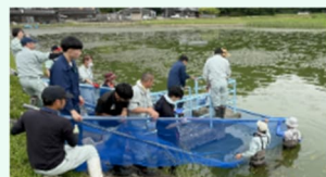
流出入口や洪水吐などに侵入防止フェンス・ネットを設置
