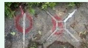
堤防や石垣の目地の隙間から生えないよう樹脂で充填
