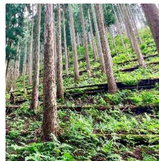
伐採木を使用した土留工 (養父市)
