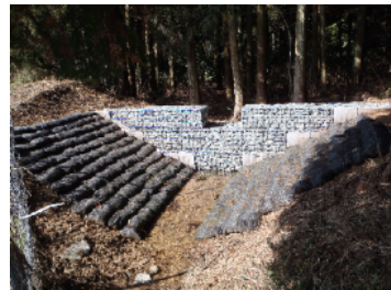
簡易防災施設(カゴ工等)整備(多可町)
