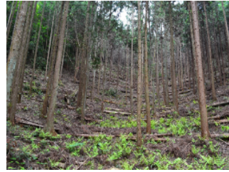
間伐木を利用した土留工設置(多可町)
