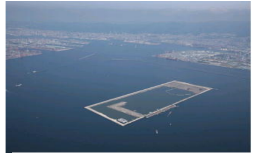
神戸沖埋立処分場
