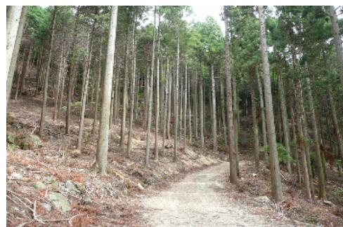
搬出間伐のために開設された作業道
