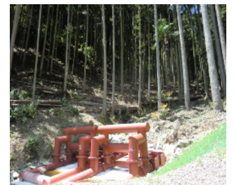
災害緩衝林整備と簡易流木止設置(姫路市)
