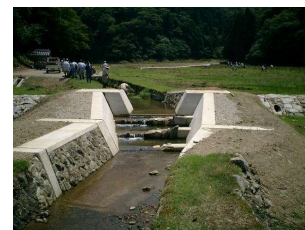
堰堤から越水させて 洪水を緩和
