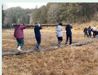
湿原内の木道の修繕
