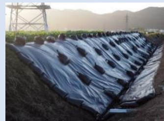
遮光シート設置後
