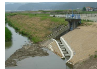
河川と水路の連続性確保 （円山川水系豊岡市）
