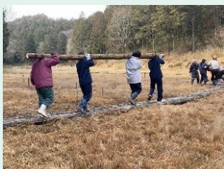
湿原内の木道の修繕
