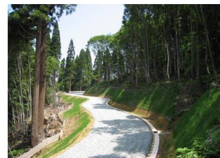
林道設計における現地形に沿った波型線形の採用 (在来種の生息・移動空間の確保)
