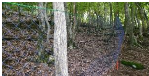
植生保護柵の設置(宍粟市)
