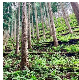
伐採木を使用した土留工（養父市）
