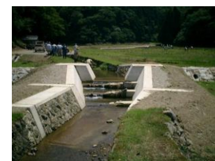
堰堤から越水させて 洪水を緩和
