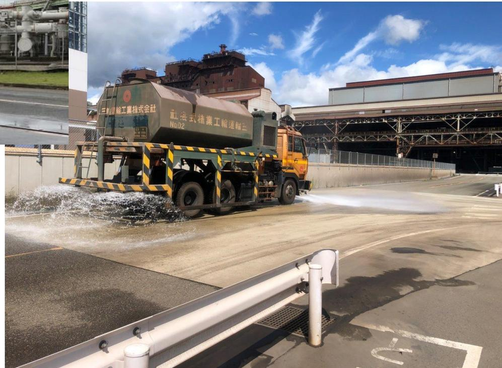
令和4年度において、工事関係車両出場時のタイヤ洗浄や構内道路等の散水を適宜行い、工事関係車両や建設機械による粉じん等の発生を低減している。
