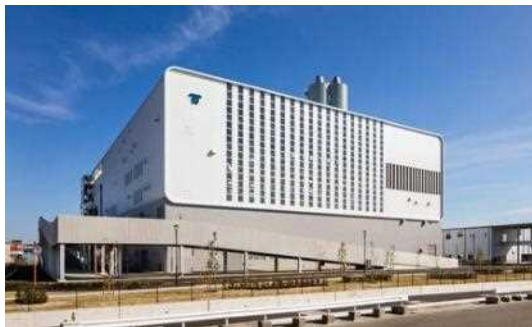
高効率ごみ発電施設 (神戸市港島クリーンセンター)
