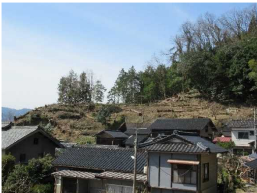
人家裏の危険木伐採(豊岡市)
