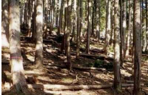
伐倒木を利用した土留工(香美町)
