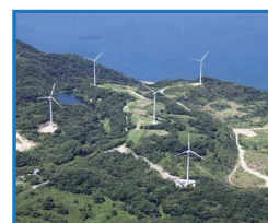
淡路風力発電所 (淡路市)
