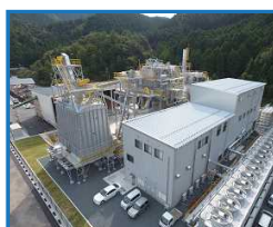
木質バイオマス発電所 (朝来市)
