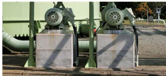
図表 92 設備のかさ上げによる浸水対策
