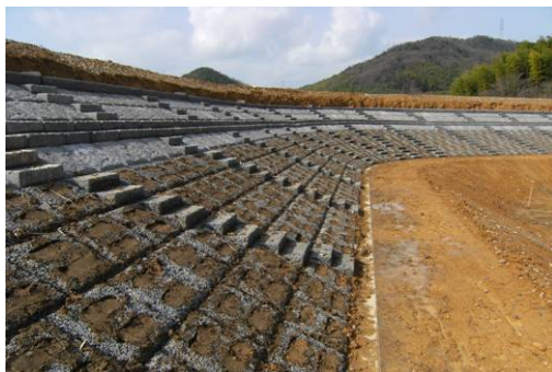
ブロックに池底土を詰めた直後
