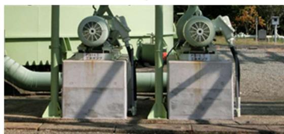
図表 91 設備のかさ上げによる浸水対策
