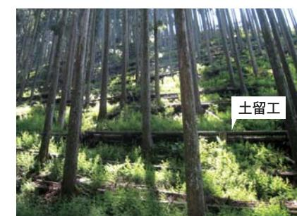
(土留工により土砂流出が抑えられ植生が回復)
