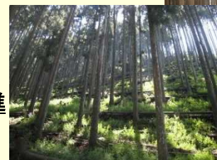
【図18 伐倒木を利用した土留工】
