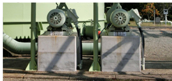
設備のかさ上げによる浸水対策
