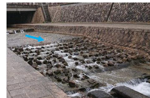
全断面式魚道（粗石付き斜路）の設置 (二)住吉川水系住吉川（神戸市東灘区）
