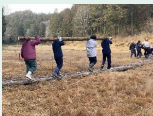
湿原内の木道の修繕
