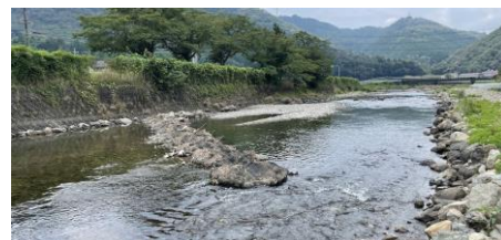
魚類の生息場に適した環境(寄州 や瀬・淵)を創出するバープ工* *河岸から上流側に向けて構造物を設置する水制工法
