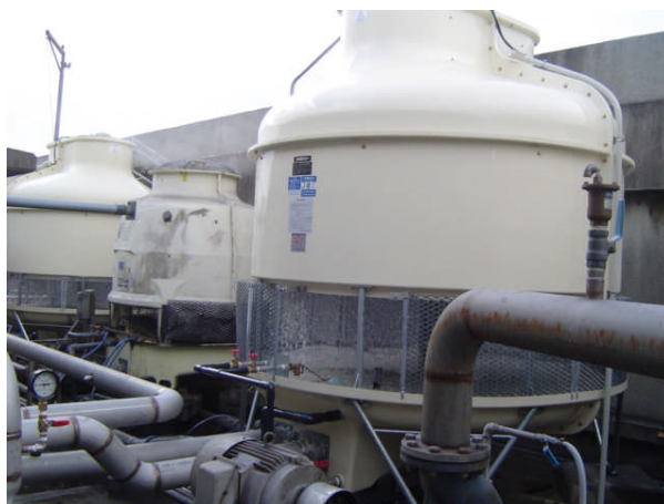
写真⑥ クーリングタワー更新
