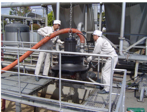
写真④ 攪拌ポンプ更新
