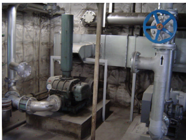
写真③ ブロアー室環境整備
