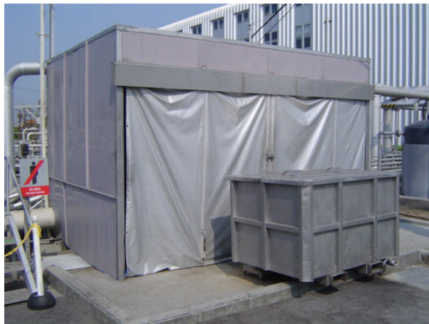
写真⑦ 臭気漏れ対策
