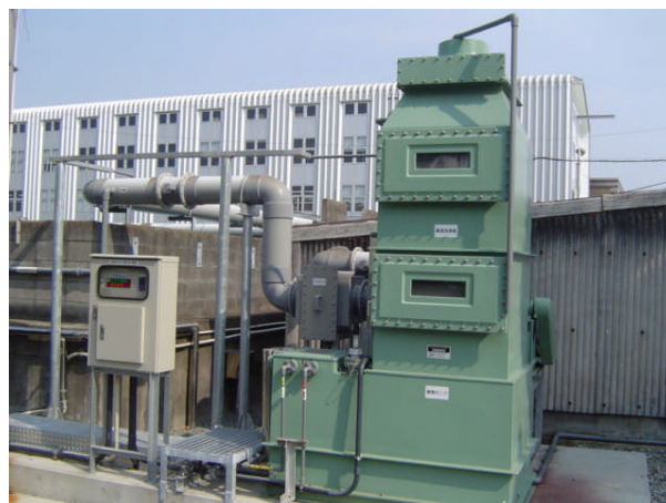
写真⑧ 脱臭装置設置
