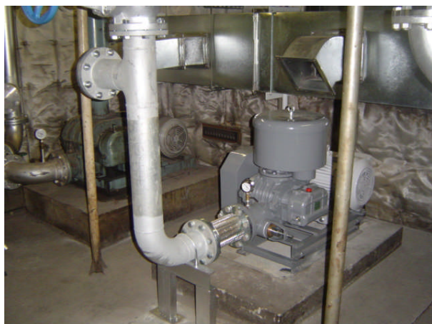
写真⑤ ブロアー更新
