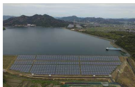
ダム堤体法面を利用したメガソーラー (平荘ダム)
