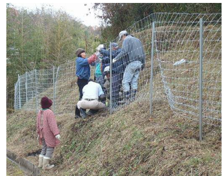
防護柵設置状況(加東市)
