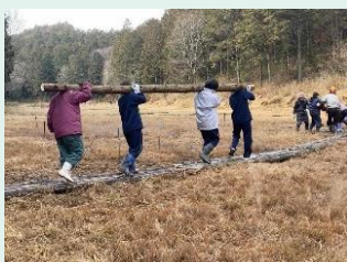
湿原内の木道の修繕
