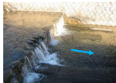
全断面式魚道（粗石付き斜路）の設置 (二)住吉川水系住吉川（神戸市東灘区）
