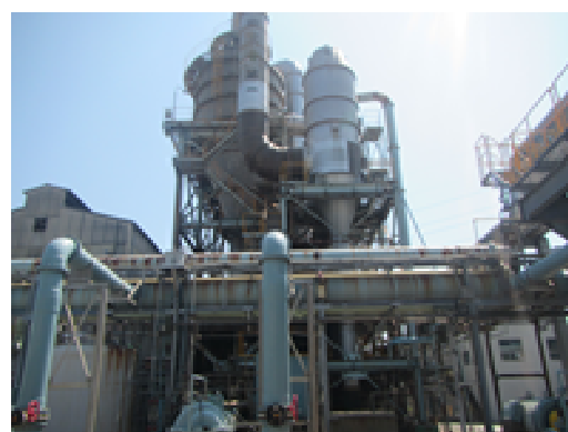
木質バイオマス発電所(赤穂市)
