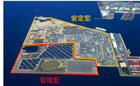
泉大津沖埋立処分場
