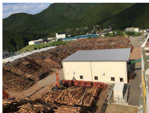
㈱関電エネルギーソリューション 未利用材ストック状況
