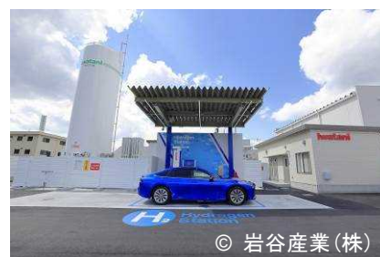
水素ステーション(姫路市)
