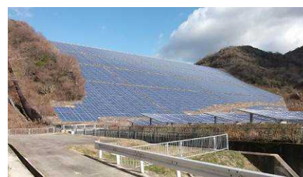
ダム堤体法面を利用したメガソーラー (神谷ダム)
