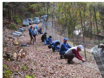
集落ぐるみでの侵入防止柵の設置(相生市)
