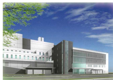
東播広域ごみ処理施設（高砂市）
