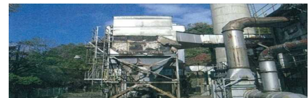
老朽化して休止した処理施設
