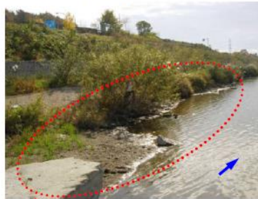
施工後3年4ヵ月
