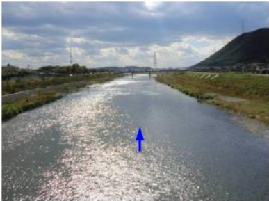
施工後3年4ヵ月
