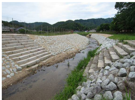
自然石を利用し環境に配慮した護岸の整備
