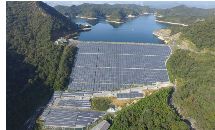
ダム堤体法面を利用したメガソーラー (神谷ダム)
