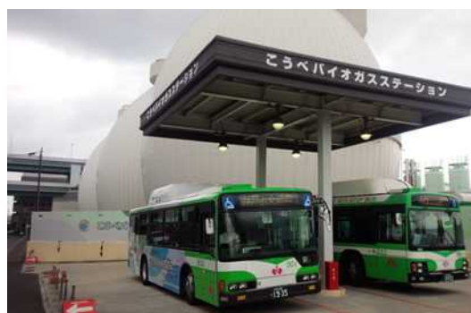
こうべバイオガスの利用
