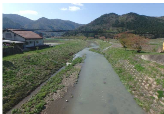
土羽護岸により水域と陸域の連続性を確保した河川整備
