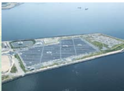
エコひょうご尼崎発電所 (尼崎市)
