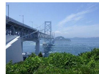
明石市側から見た淡路島
