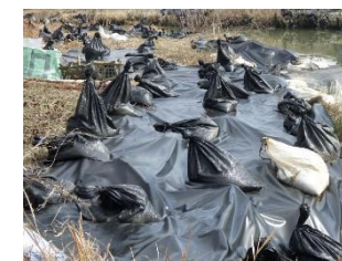
遮光シート(100%)の設置
