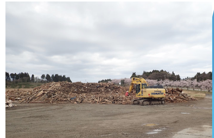
解体廃棄物仮置場
