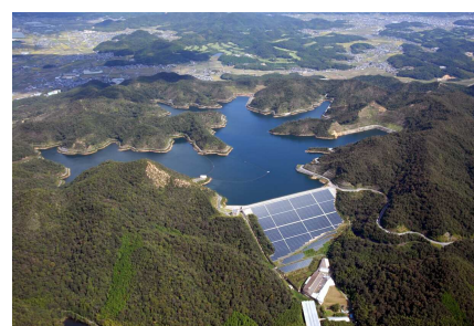
ダム堤体法面を利用したメガソーラー (神谷ダム)
