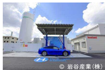
水素ステーション(姫路市)
