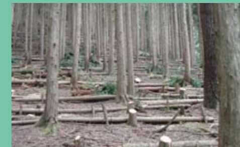
▲間伐木を利用した土留工
