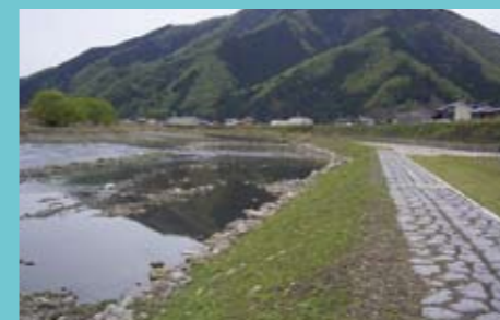
▲ コンクリートブロックに覆土をして植生を回復した河川整備(大屋川)
