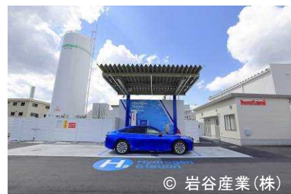
水素ステーション(姫路市)
