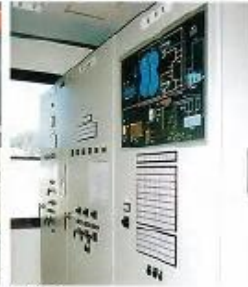
▲汚泥ポンプ室
