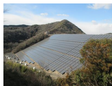
ダム堤体法面を利用したメガソーラー (神谷ダム)(姫路市)
