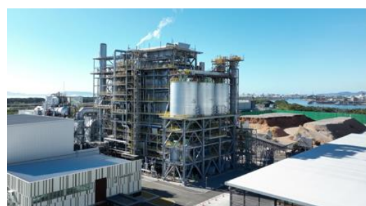
広畑バイオマス発電所(株)(姫路市)
