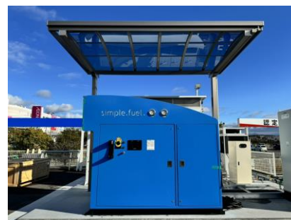
ネッツテラス三木水素ステーション (パッケージ型水素供給設備)
