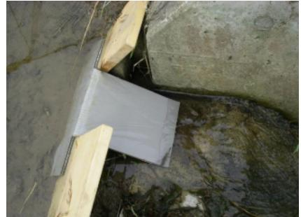
水位調整や補修が容易な堰板
