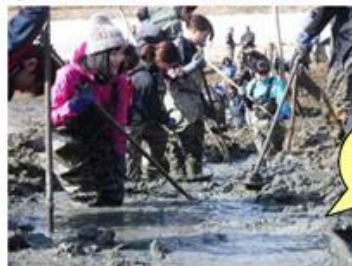
④人力作業による掻き出し
