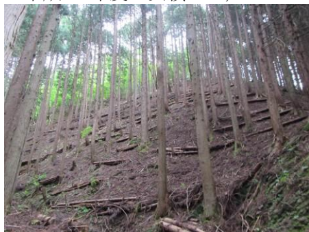
間伐木を利用した土留工(朝来市)
