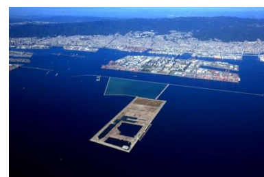
神戸沖埋立処分場(令和元年11月撮影)
