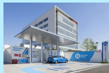
水素ステーション(尼崎市)
