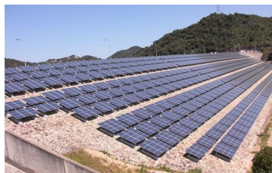
ダム堤体法面を利用したメガソーラー (権現ダム)(加古川市)
