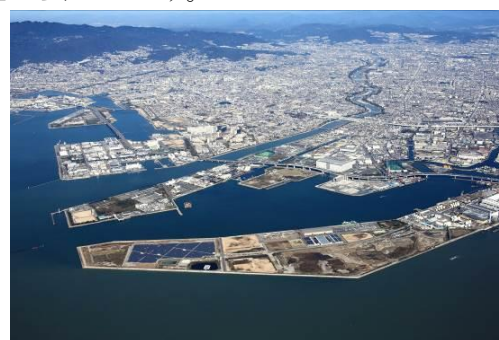
尼崎沖埋立処分場(平成29年11月撮影)
