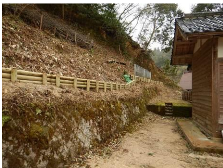
簡易防災施設(出石町)
