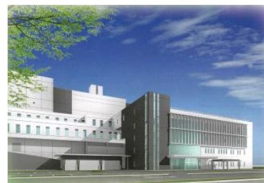
東播広域ごみ処理施設(高砂市)
