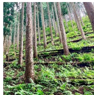
伐採木を使用した土留工 (養父市)
