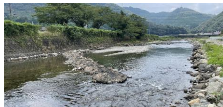
魚類の生息場に適した環境(寄州 や瀬・淵)を創出するバープエ* *河岸から上流側に向けて構造物を設置する水制工法
