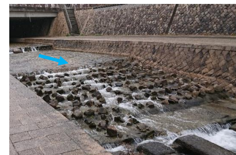
全断面式魚道（粗石付き斜路）の設置 （二）住吉川水系住吉川（神戸市東灘区）
