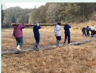
湿原内の木道の修繕
