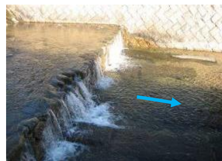
全断面式魚道（粗石付き斜路）の設置 （二）住吉川水系住吉川（神戸市東灘区）
