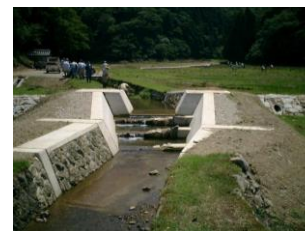
堰堤から越水させて 洪水を緩和
