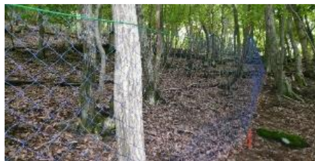
植生保護柵の設置(宍粟市)
