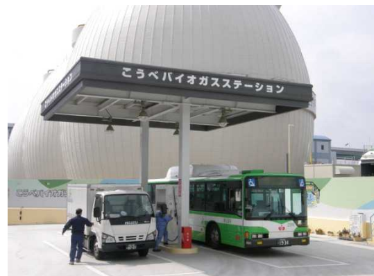
こうべバイオガスステーション
