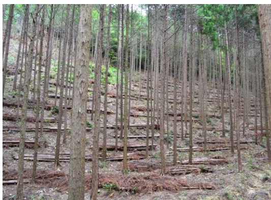
災害緩衝林の整備（豊岡市）
