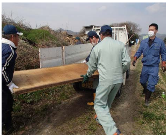
エコ手形制度による廃棄物の撤去 (東播磨県民局)
