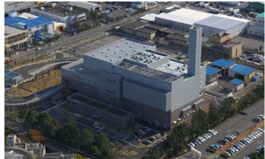
西宮市東部総合処理センター焼却施設
