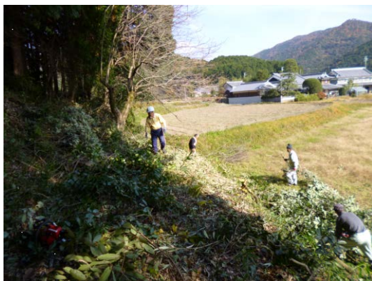
住民によるバッファゾーン整備（市川町）
