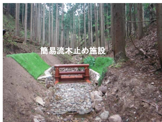
間伐木を利用した土留工（多可町）
