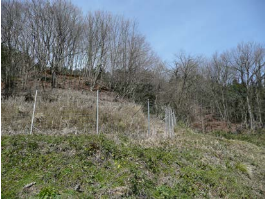
バッファゾーン区域での集落柵設置 (養父市)
