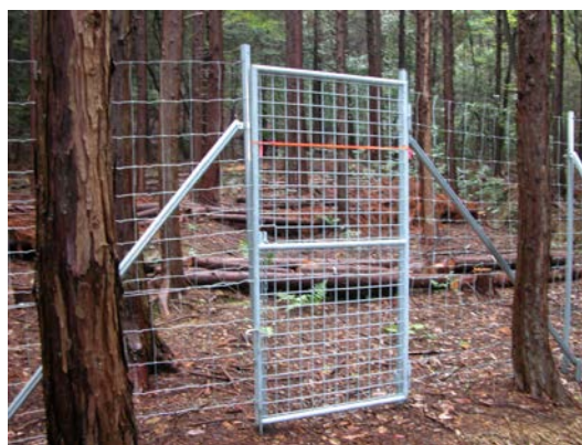
シカ防護柵（出入口）（市川町）
