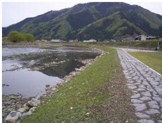
コンクリートブロックに覆土して植生を回復した河川整備
