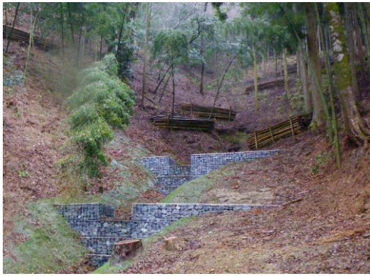
簡易防災施設の整備（朝来市）
