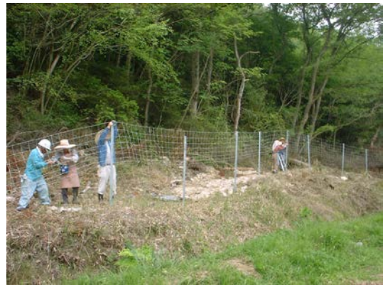
シカ被害防護柵の設置(姫路市)
