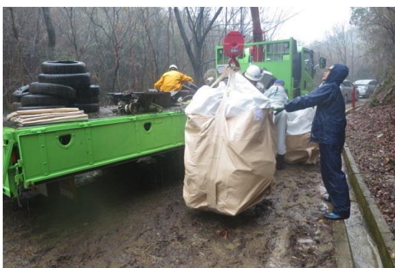
住民等による不法投棄物の撤去風景(北播磨県民局)
