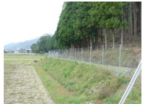
防護柵(多可町)
