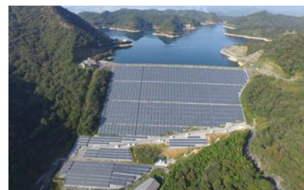
ダム堤体法面を利用したメガソーラー(神谷ダム)
