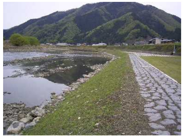
コンクリートブロックに覆土して植生を回復した河川整備
