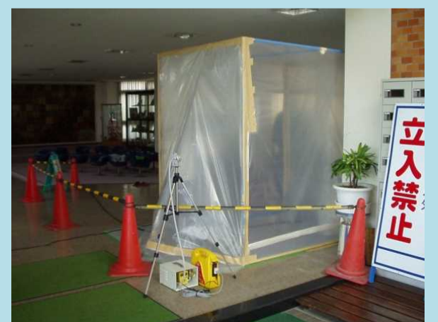
作業現場出入口での試料採取
