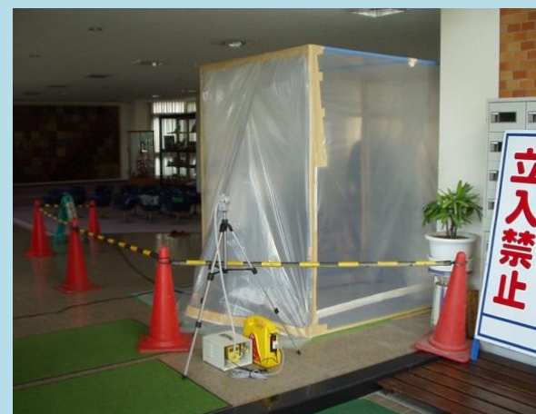
在工地出入口附近抽样检测
