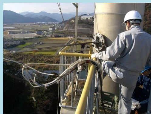
检测工厂烟尘排放量
