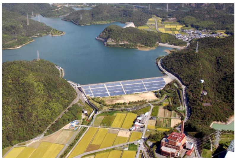
水库堤坝上设有光伏发电设备
