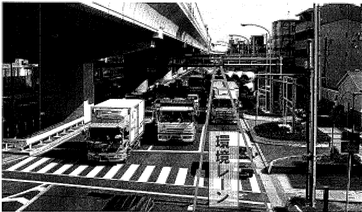
写真 西宮市戎前交差点(下り)
