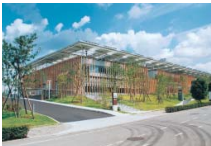
▲西播磨庁舎は太陽光発電パネルをはりめぐらせた屋根、間伐材を利用したルーバー等、徹底して環境に配慮した建物になっています。
