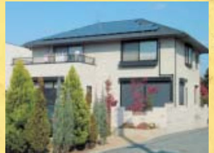
▲太陽光発電パネルを設置した住宅
